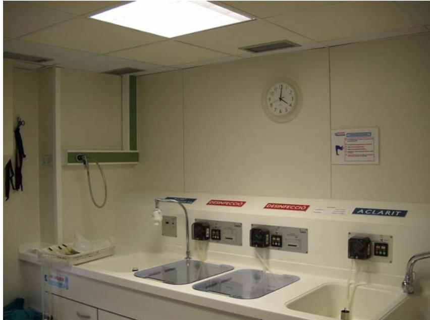
**Anios®: sistema semiautomático de desinfección con elevada capacidad operativa y que permite la utilización de cualquier desinfectante. Los endoscopios se colocan sucesivamente en las cubetas de lavado, aclarado, desinfección y aclarado final.**
